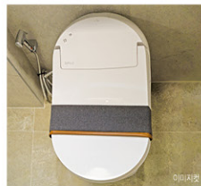
대림 도비도스 비데 설치
